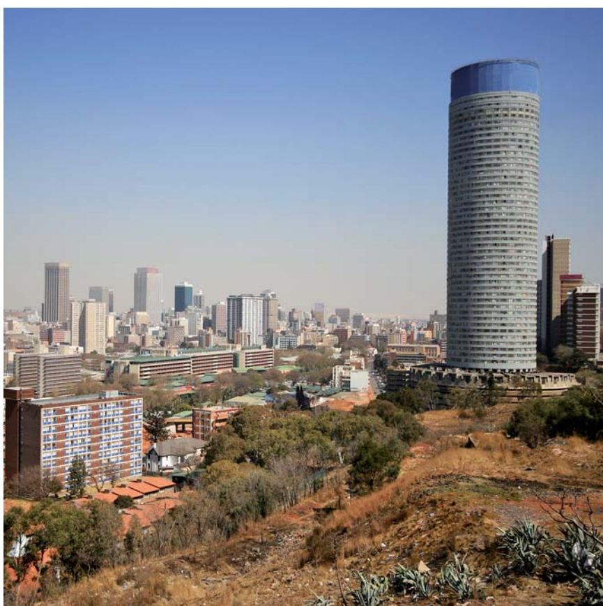
Schwellenländer: intakte Aussichten, Beispiel Johannesburg
