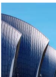
Thames River Barrier: zuverlässiger Schutz
